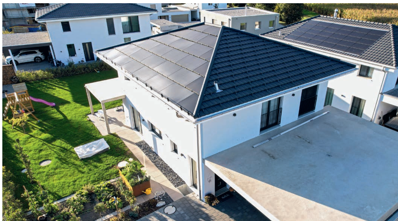
Moduli fotovoltaici installati sul tetto di una casa unifamiliare a Lüterkofen-Ichterswil SO.
