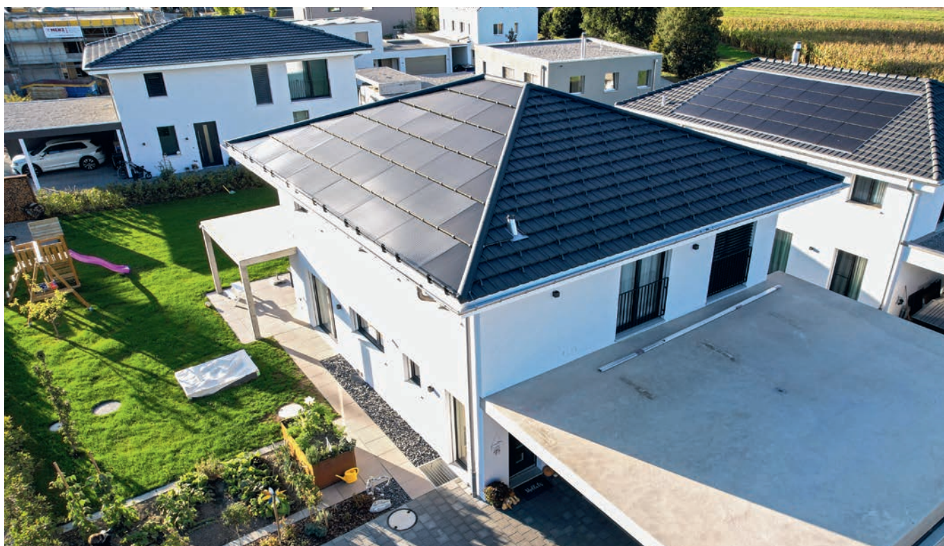
Panneaux photovoltaïques sur le toit d'une maison individuelle à Lüterkofen-Ichterswil SO.
