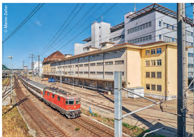
Win-win-Situation für alle: Statt brachliegender «Unort» ist die Centrale am Gallenweg Pratteln Arbeitsplatz und Teil des öffentlichen Lebens.
