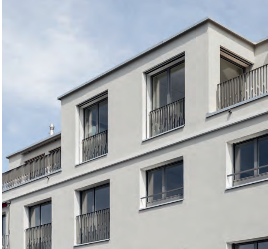
Das dezent und harmonisch erhöhte Mehrfamilienhaus Sumatrastrasse mit neuem Attikageschoss.
