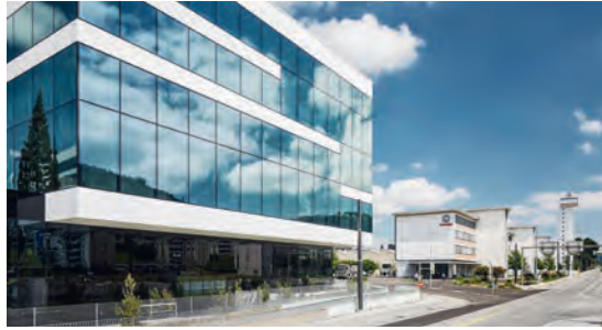
Das Besucherzentrum «Schindler City Center» in Ebikon LU gibt über vier Etagen einen Einblick in die Lösungen und Dienstleistungen der Schindler Aufzüge AG.
