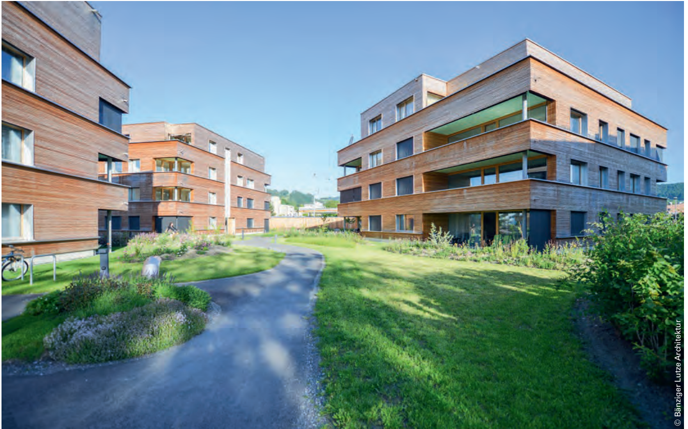
Der Obstgarten in Widnau ist die erste im Kanton St.Gallen realisierte Siedlung nach Minergie-P-Eco-Standard. Ein Elektroauto kann von allen Mietern genutzt werden und auch die Ernte der Obstbäume wird geteilt.
