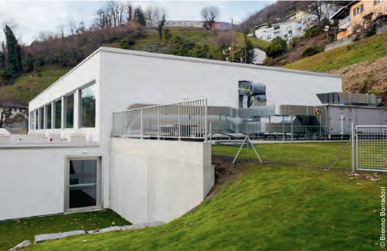
L'école primaire Al Burio de Gordola, 1 re étape des travaux en 2021. Altération de l'architecture suite à la rénovation et malgré l'intention manifeste du maître d'ouvrage de conserver la valeur historique et architecturale du bâtiment.
