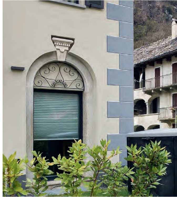
Photo d'un bâtiment historique avec isolation thermique dans la Valle Maggia.
