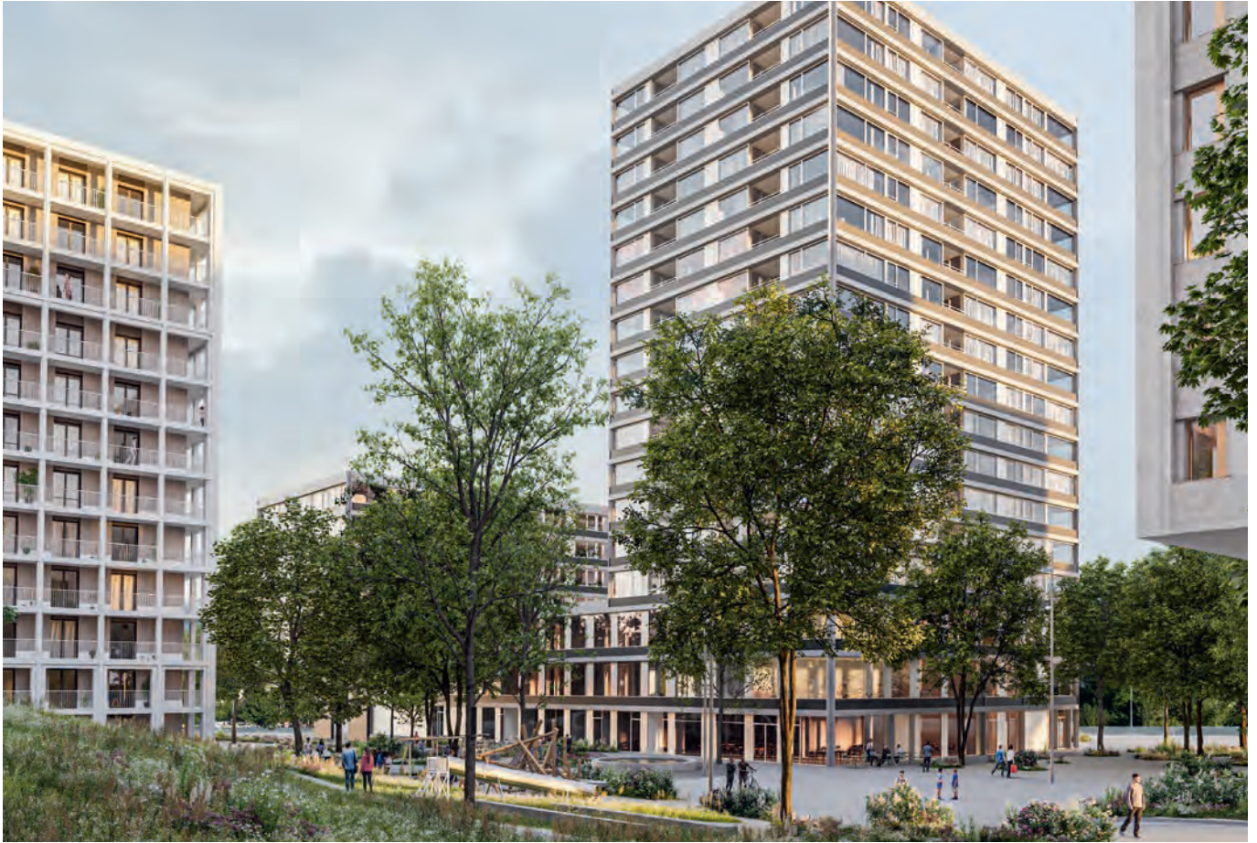
Le nouveau centre d'assurances sociales à Lucerne se passe complètement de chauffage.
