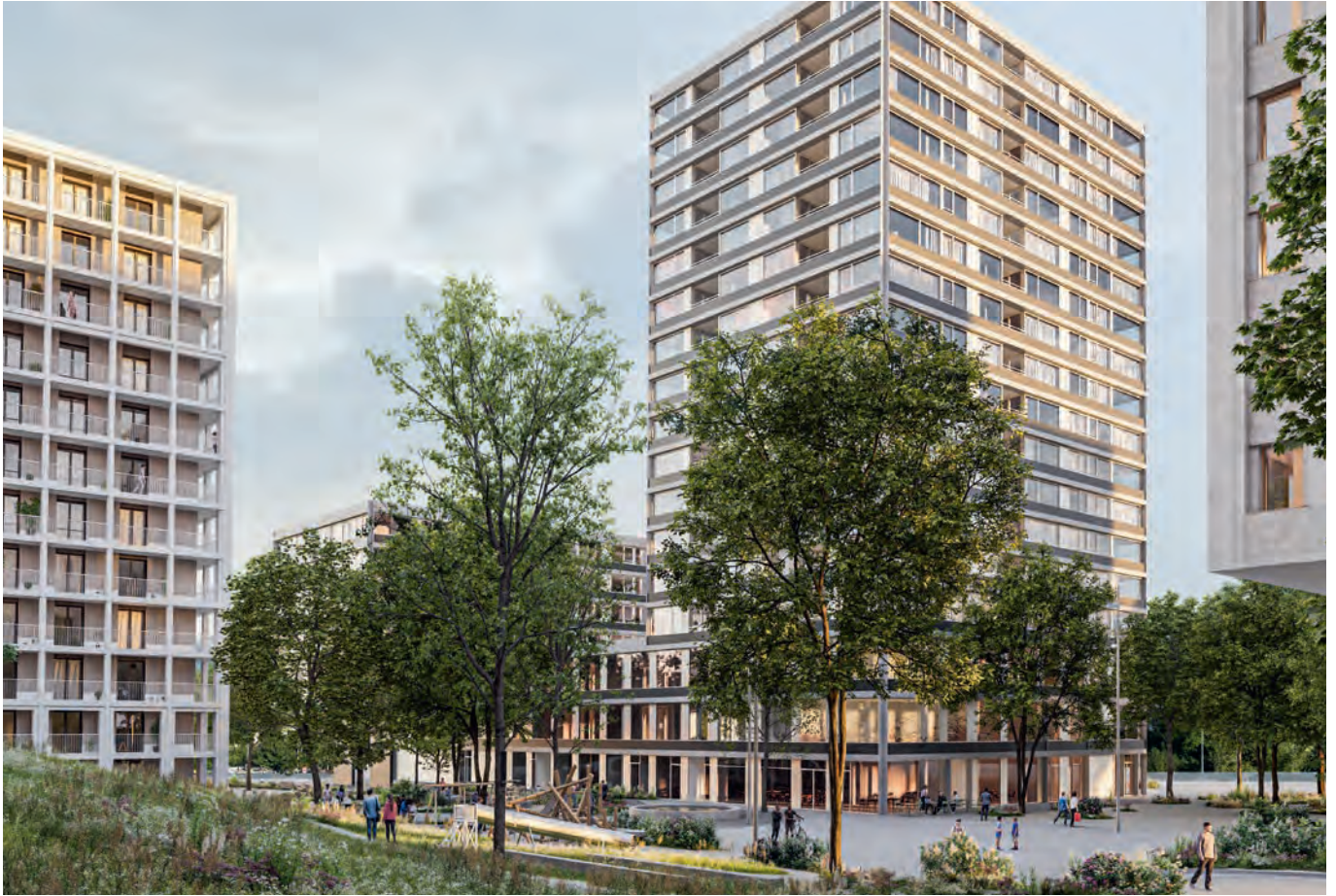
Das neue Sozialversicherungsgebäude in Luzern kommt ganz ohne Heizung aus.
